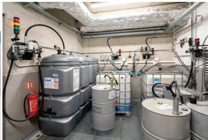
7 Centrální zázemí pro sběr použitého a výdej nových olejů a kapaliny do ostřikovačů.
